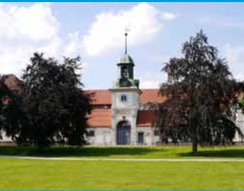
[Torgebäude der JVA Celle]
